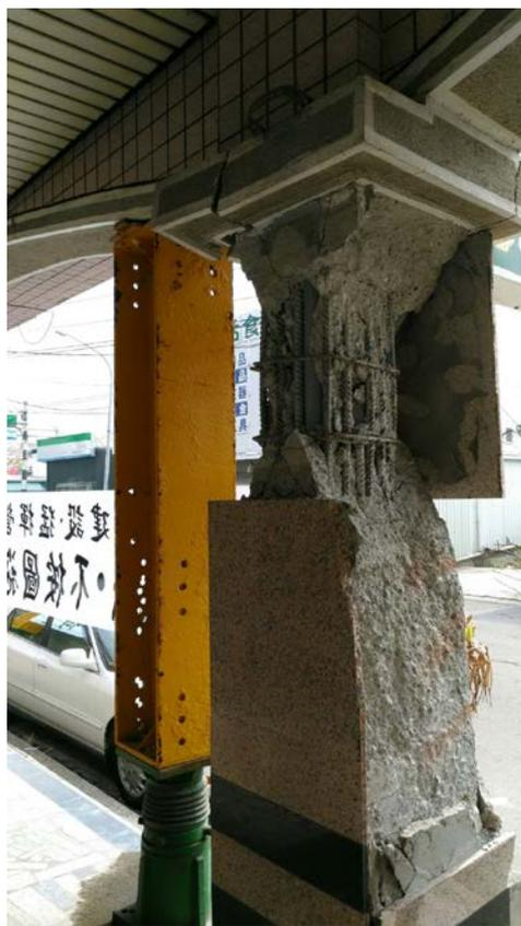
(圖五) 騎樓柱地震受損
