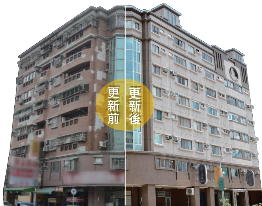
整建維護 高雄市公園人生大樓
